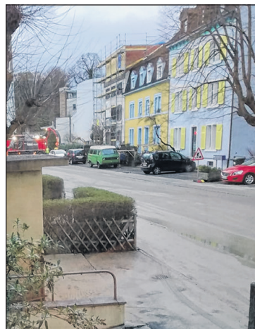
Nach dem Rohrleitungsbruch war die Fahrbahn verschlamm.
