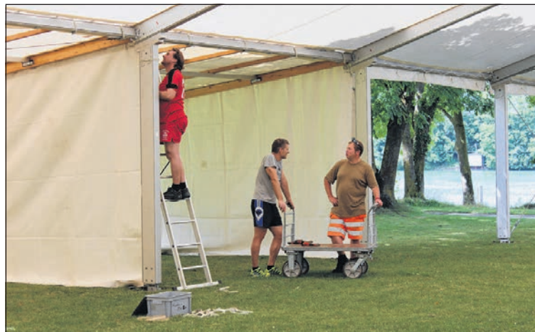
Es geht vorwärts: Die Profile sind aufgestellt. Jetzt müssen nur noch die Planen montiert werden, dann steht das grosse Festzelt.
