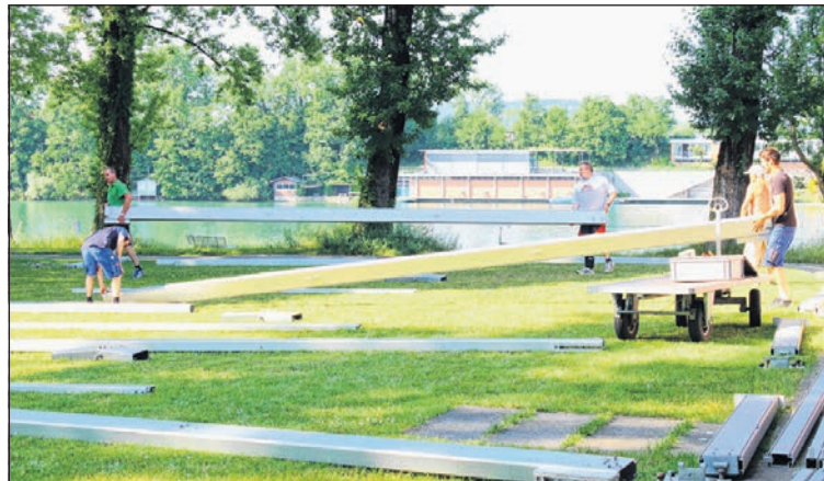
Starke Männer gefragt: Die Profile für das grosse Festzelt werden auf die Wiese der Kraftwerkinsel transportiert und bereit gelegt.
