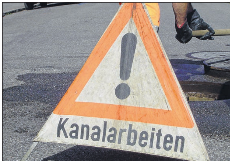
Kanalsanierung. Ab 23. September 2019 wird in der Schulstrasse die Kanalisation saniert.
