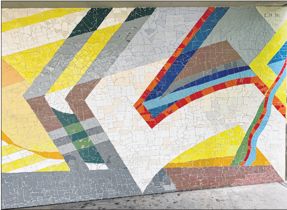
Der erste Teil der Sanierung: das Wandmosaik von Konrad Hofer an der Rheinpark-Aula.
