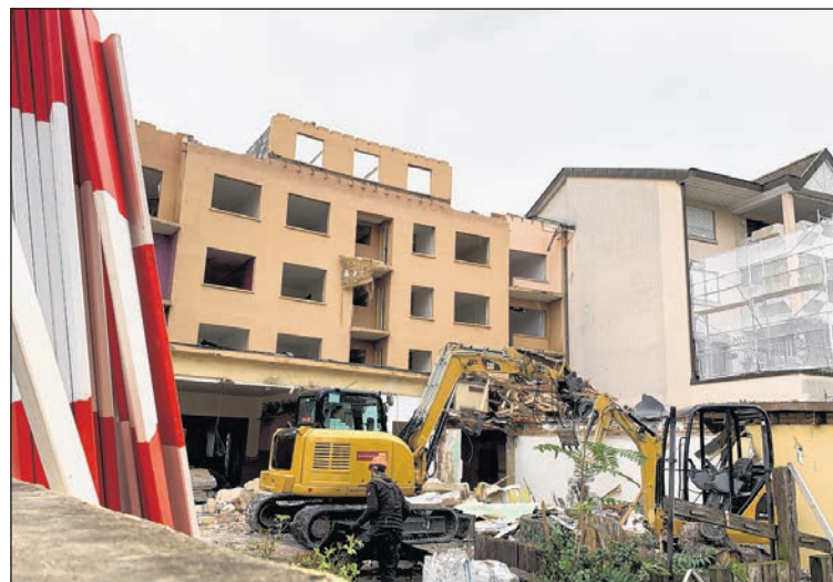
Einst eine populäre Dorfbeiz im Herzen Birsfeldens – seit Dezember 2019 eine Grossbaustelle.
