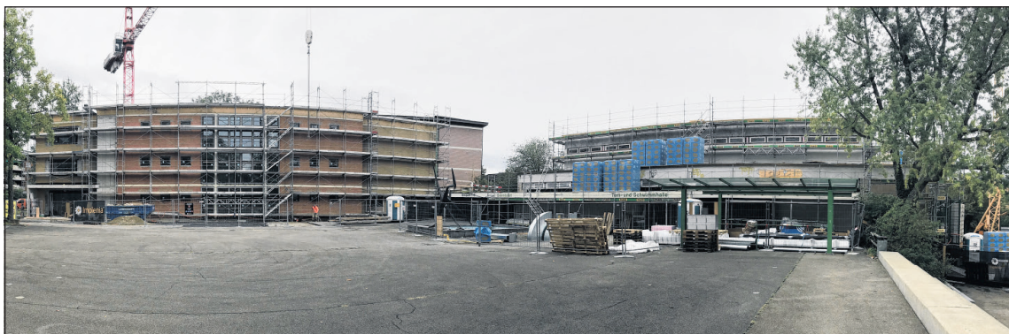
Kräne, Gerüste und Baumaterial prägen derzeit das Bild rund um die Schulanlage Kirchmatt. Links Birsark 1, wo die Sanierung bald abgeschlossen ist, in der Mitte (in rosa im Hintergrund) Birsark 2, rechts die Turn- und Schwimmbhalle, die ebenfalls renoviert wird.
