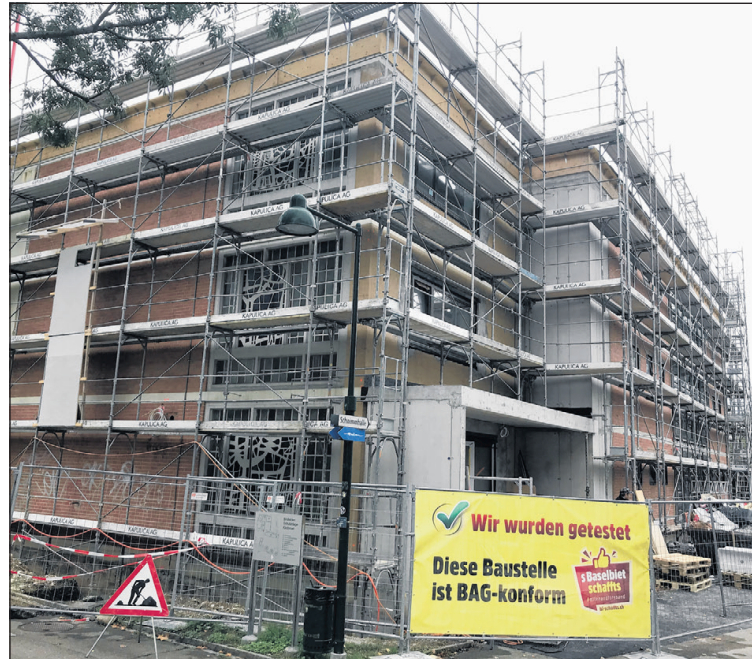
Noch wird während der Herbstferien fleissig gearbeitet am Schulhaus Birsark 1, damit am ersten Schultag eingezogen werden kann – die Aussenfassade soll bis Ende Oktober fertiggestellt sein.
