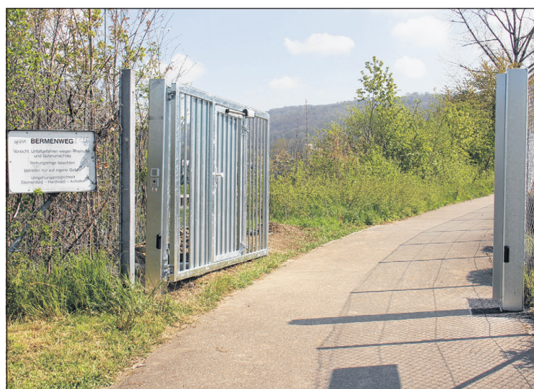
Gemachte Tatsachen? Beim Eingang des Bermenwegs findet sich schon vor der offiziellen Schliessung ein neu montiertes Tor.
