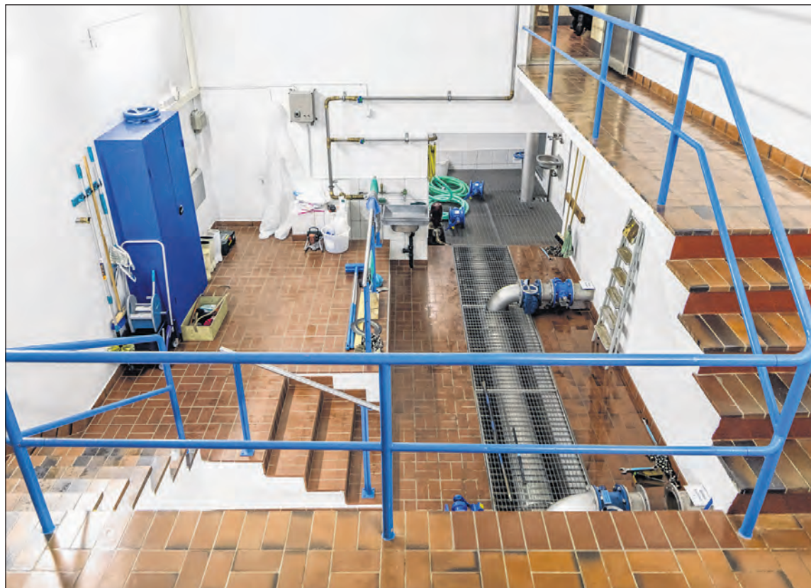
Blick in den Rohrkeller des heutigen Reservoirs.
