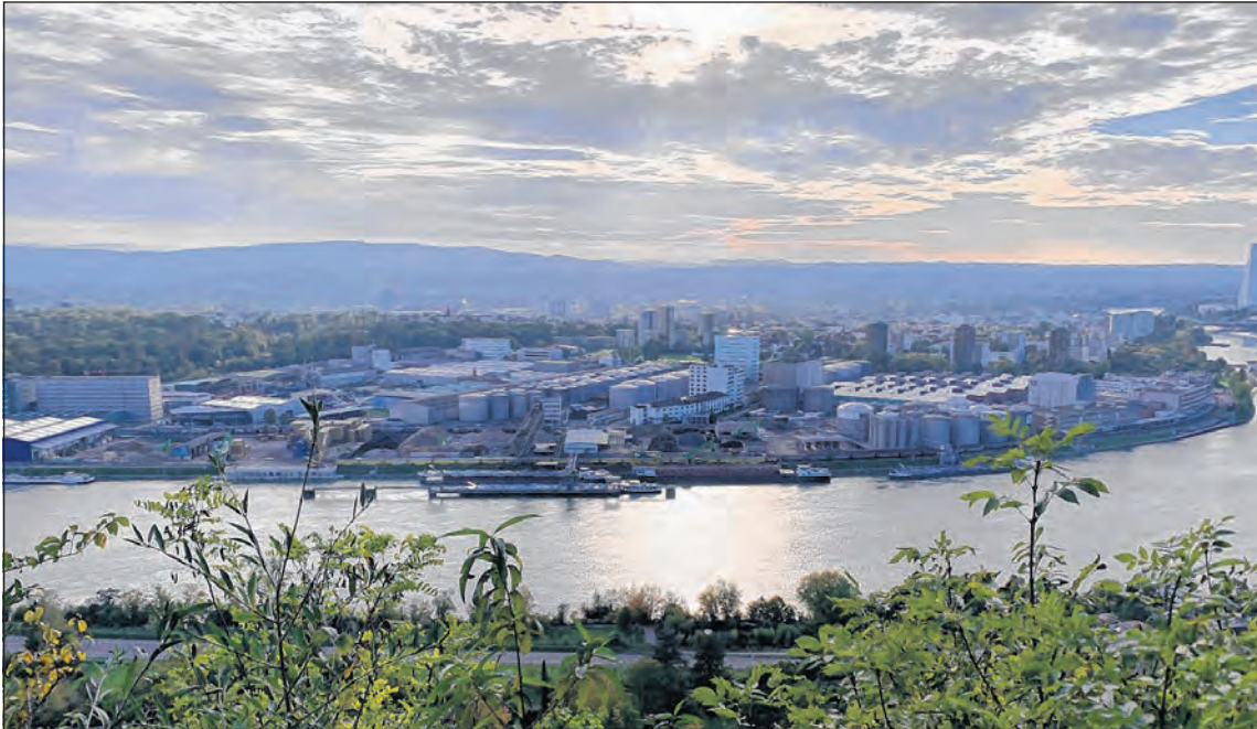
Bei der Baustelle im Birsfelder Hafen werden ab Mitte Juni Spundwandbohlen hydraulisch in den Boden gerammt. Dafür werden im Moment Arbeitsplattformen erstellt.
