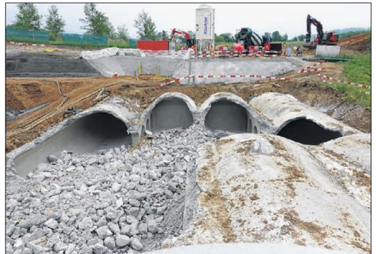
Die Bauzeit dauerte rund zwei Jahre. Während der ersten Bauphase wurden die ältesten beiden Kammern zurückgebaut.
