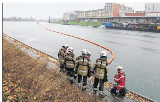
Einsatzübung Nummer eins: Eine Ölsperre wird im Schleusenvorhafen installiert.
