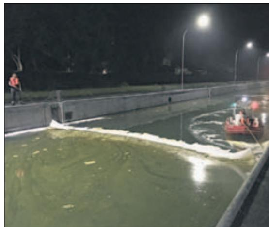
Aufwischen. Mit Ölbindevlies, das wie auf einer «Wöschhänggi» über das Wasser gezogen wird, können die Schlieren gezielt gebunden und zum Saugwagen getrieben werden.
