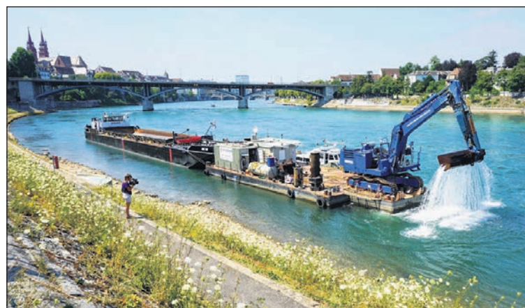
Mit einem 70 Tonnen schweren Bagger der Firma Hülskens wird der Kies aus der Fahrhinne genommen und an anderen Orten in Ufernähe aufgeschüttet.
