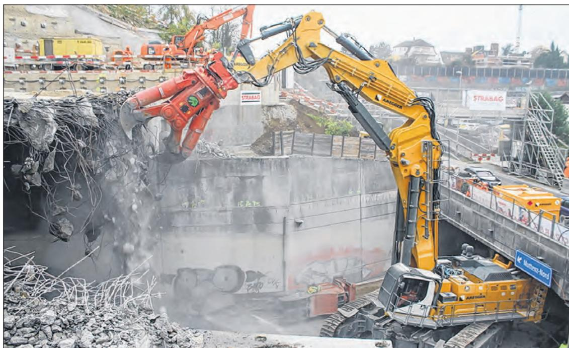
Die Ausfahrt Muttenz Nord soll mit einem Verzögerungstreifen sicherer gemacht werden. Europas grösster Rückbaubagger «A-Rex» wurde zur Hilfe gerufen, um den Hagnautunnel abzureissen. Am kommenden Wochenende wird der Tunnel nochmals für die Abbrucharbeiten gesperrt. Foto Tamara Steingruber **Seite 3**
