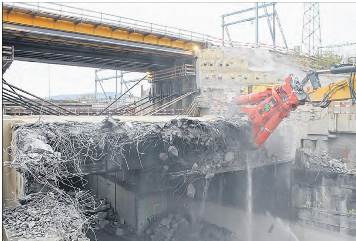
Ein gewaltiges Unterfangen: Innerhalb eines Wochenendes wurde mit Hilfe des europaweit grössten Rückbaubaggers «A-Rex» ein Grossteil des Hagnau-Tunnels abgerissen.
