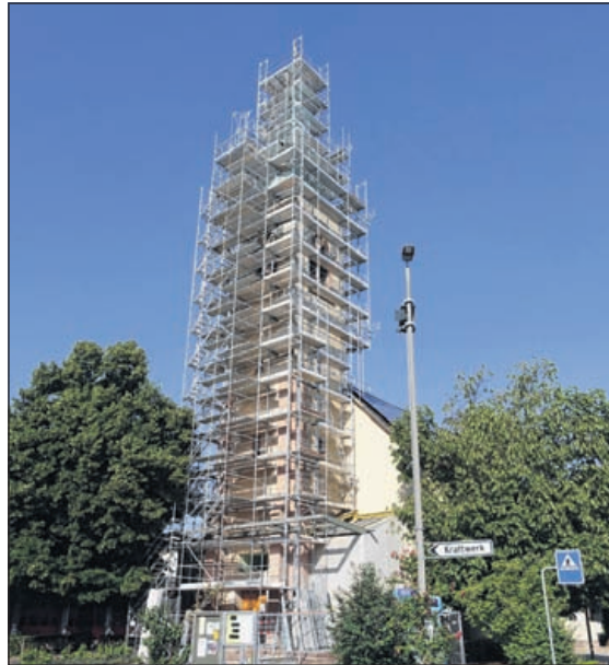
Damit die Spenglerarbeiten beginnen können, wurde ab Mitte Juni ein Gerüst erstellt.
